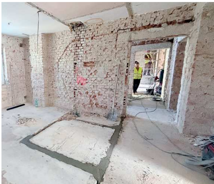
Revitalizace bytového domu Na Hrázce 32
