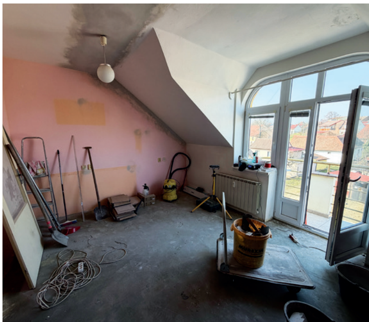
Probíhající oprava bytu na DPS
