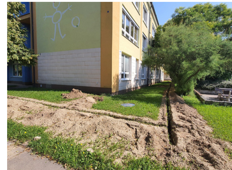
Oprava systému ochrany před bleskem na budově základní školy a mateřské školy
