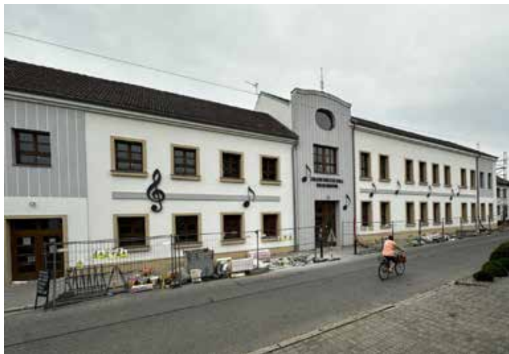
Oprava fasády základní umělecké školy
