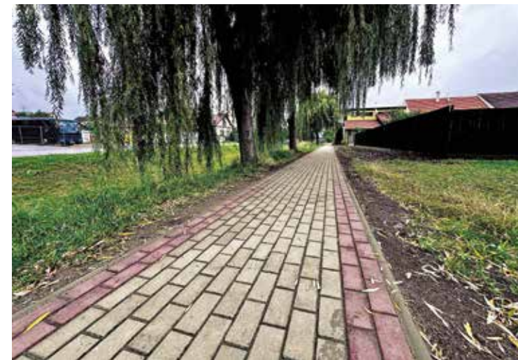
Opravený chodník od přemostění po ulici Dlouhá podél potoku Prušánka
