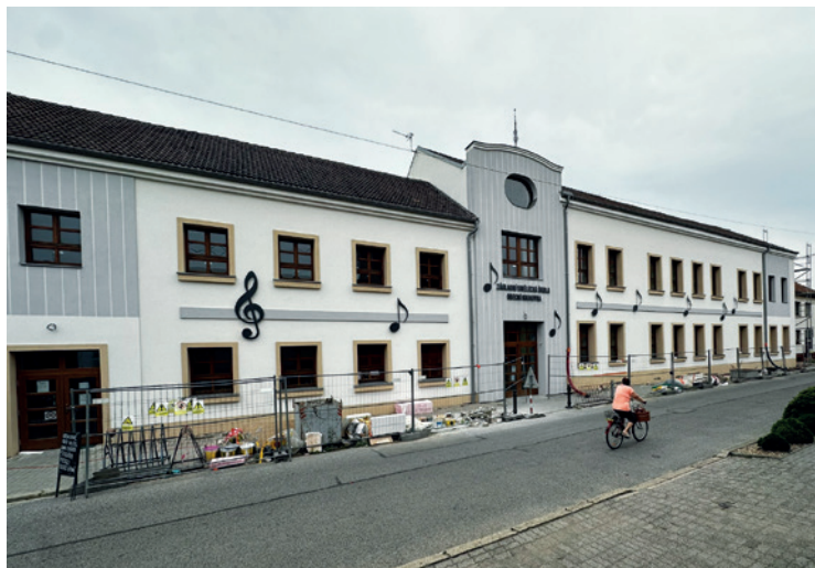
Oprava fasády základní umělecké školy
