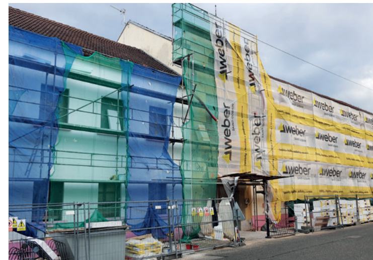
Oprava fasády ZUŠ
