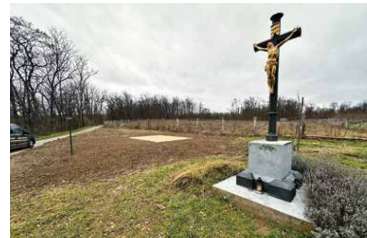
Výstavba odpočívadla u Železného kříže
