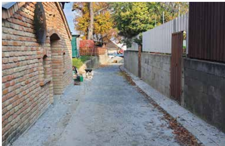
Oprava povrchu komunikace v ulici Vinařská
