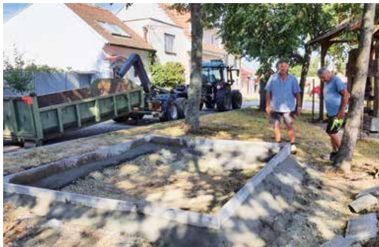
Budování cykloodpočívadla v ulici Sklepní u starého presu
