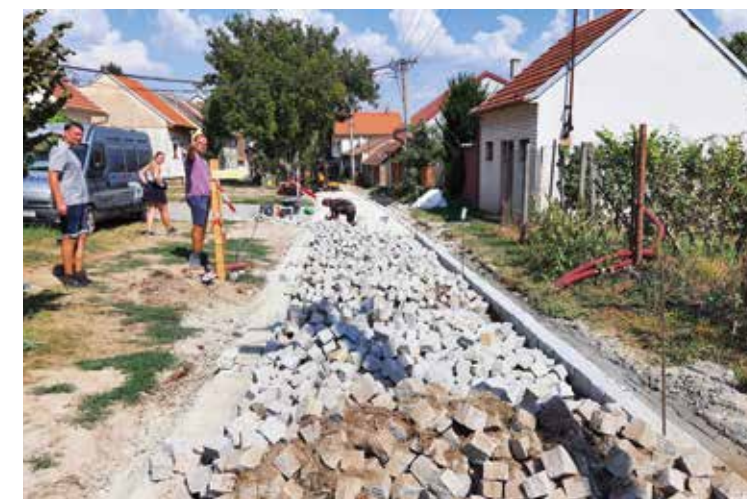
Rekonstrukce povrchu v ulici Vinařská
