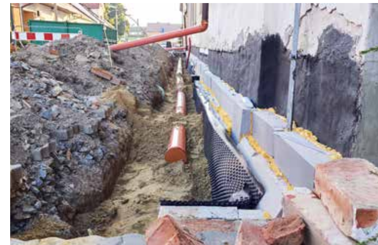
Sanace obvodového zdiva budovy Základní umělecké školy
