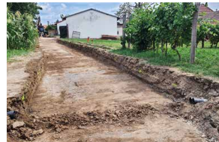
Oprava polní cesty v ulici Hroznová
