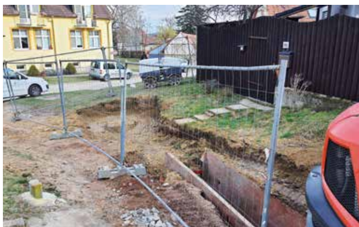
Příprava kanalizace a vodovodu v ulici Višňová, Úzká, Slepá
