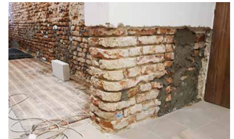
Sanace zdiva v Obecní knihovně
