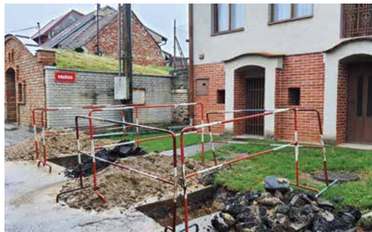
Realizace propojení vodovodu v ulici Vinařská
