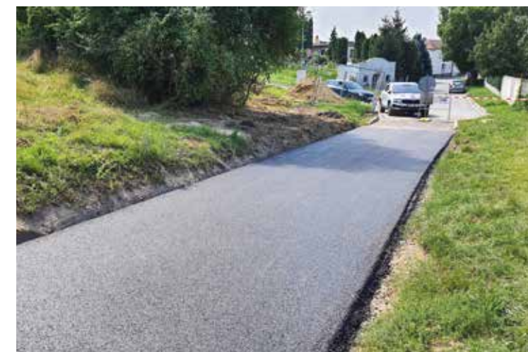
Oprava panelové cesty k zásobníku SPP
