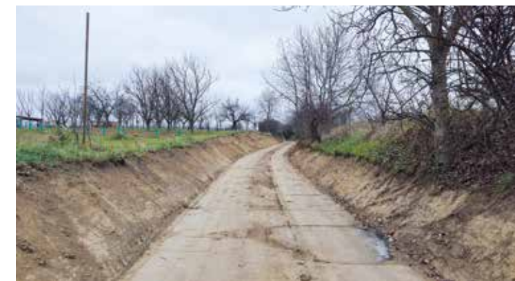
Příprava na opravu povrchu panelové cesty k plynovému zásobníku
