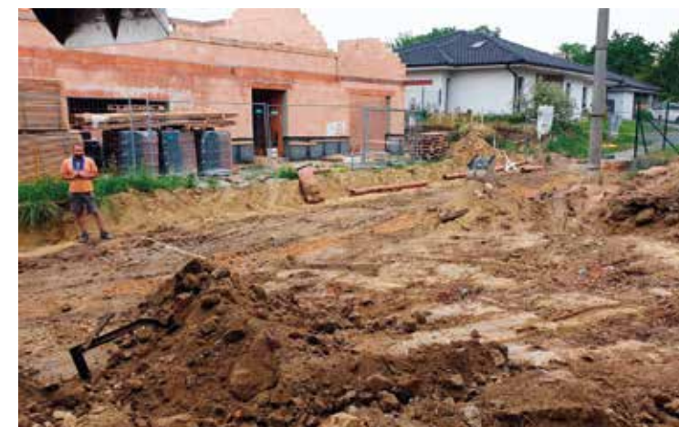
Oprava křižovatky v ulici Horní Pustá
