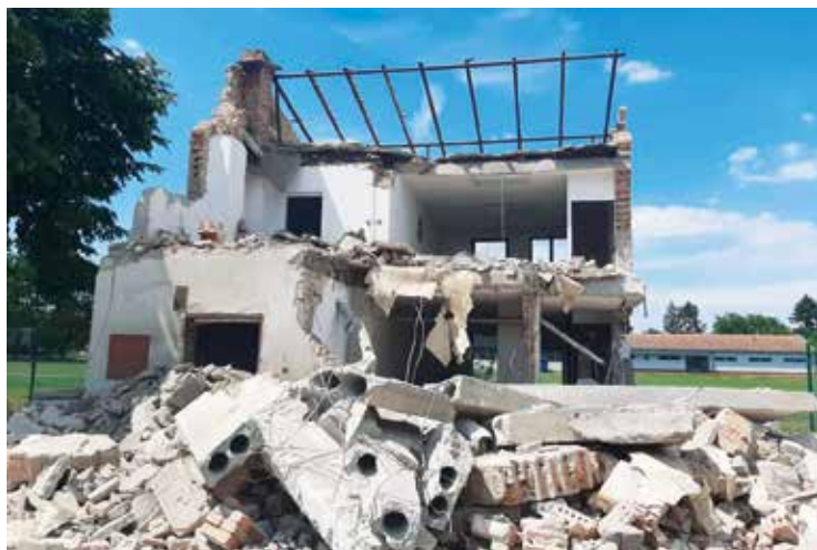
Demolice staré klubovny na ulici Sportovní
