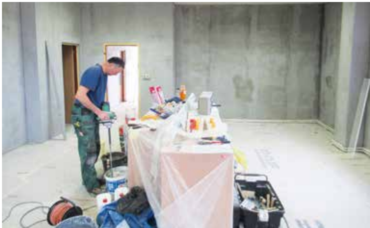
Rekonstrukce zbrojnice SDH
