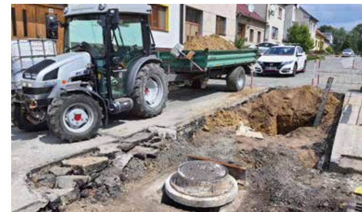
Oprava kanalizace v ulici Za Humny
