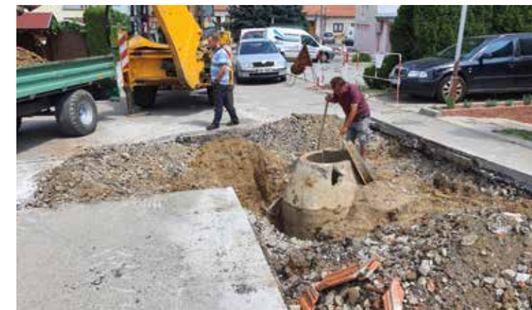
Oprava kanalizační šachty v ulici Okružní
