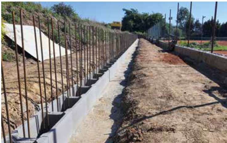
Výstavba opěrné zdi
