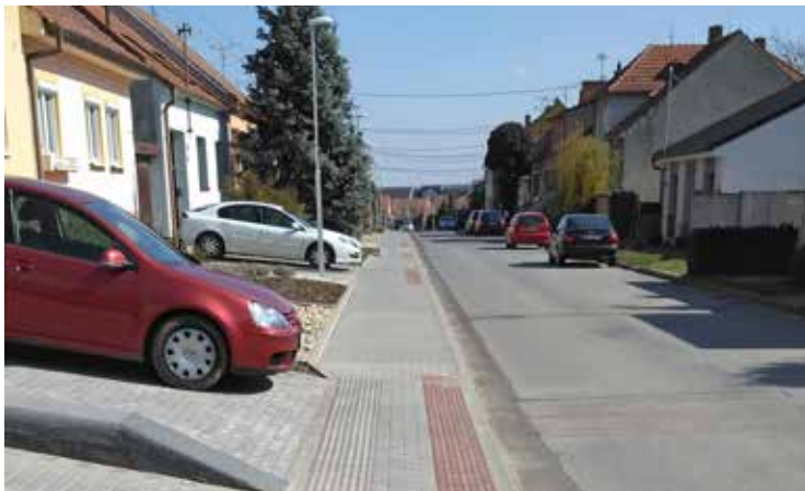
Realizovaný projekt – chodník v ulici Spodní Pustá zdroj: archiv MAS
