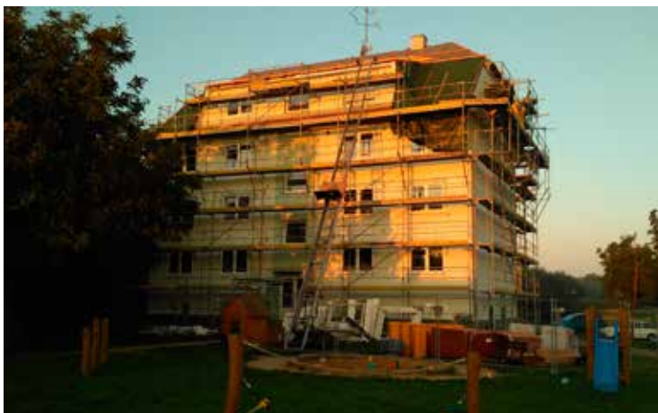
Zateplení a rekonstrukce kotelny Na Hrázce 62 v Dolních Bojanovicích
