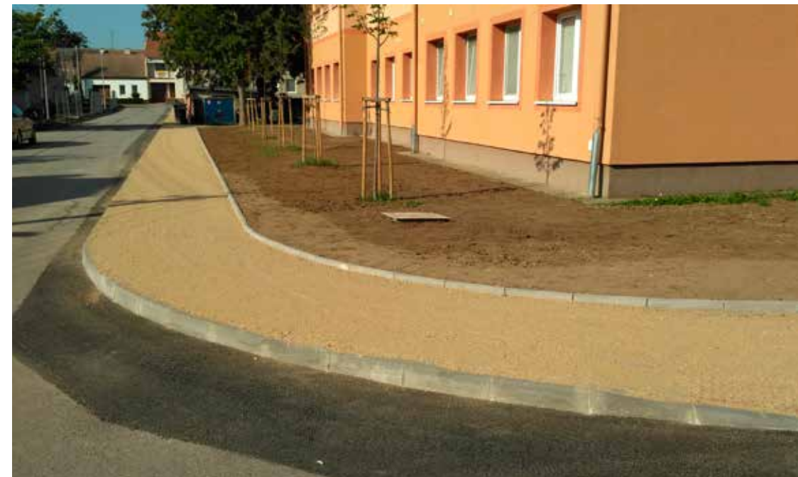
Výstavba nového chodníku v ulici Kravácká
