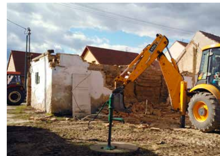
Demolice domu v ulici Na Hrázce
