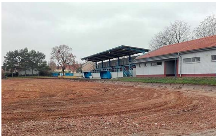
Rekonstrukce plochy na hřišti
