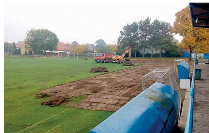
Rekonstrukce plochy na hřišti
