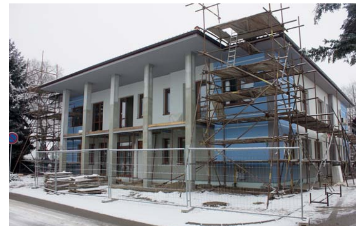
Rekonstrukce Zdravotního střediska
