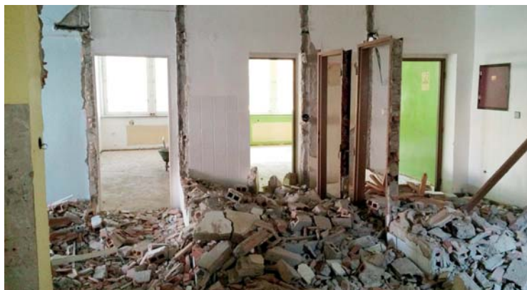
Rekonstrukce zdravotního střediska
