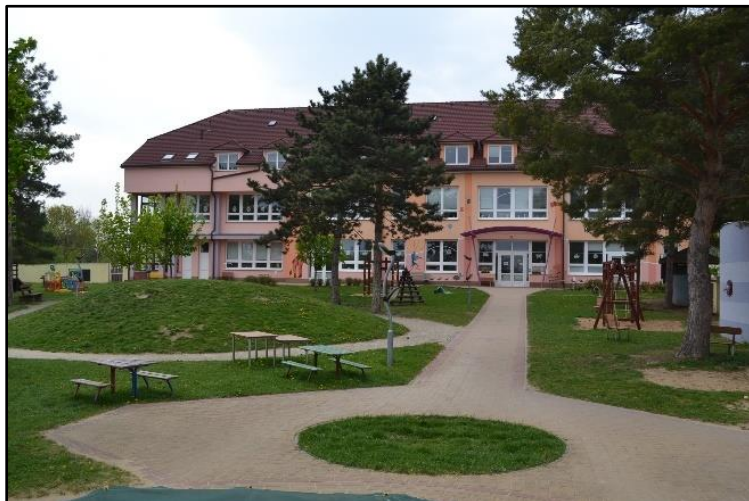
Obrázek č. 6: Mateřská škola Dolní Bojanovice
